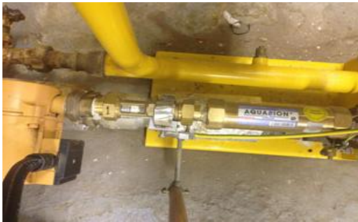
Abbildung 7 u. 8: Die 2-Durchflussmesser neben den AQUABION® Systemen. Diese wurden nach den Pumpen installiert und zeigen die Erhöhung der Strömungsgeschwindigkeit an.
