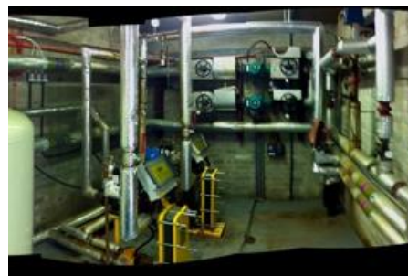
Abbildung 2,3: Andere Wasserbehandlungssysteme konnten die Plattenwärmetauscher vor Verkalkung nicht schützen. Die Plattenwärmetauscher wurden regelmäßig gewartet, wobei alle 6 Monate eine Entkalkung durchgeführt wurde.
