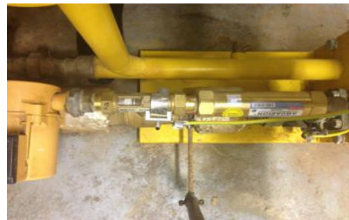
Abbildung 7 u. 8: Die 2-Durchflussmesser neben den AQUABION® Systemen. Diese wurden nach den Pumpen installiert und zeigen die Erhöhung der Strömungsgeschwindigkeit an.
